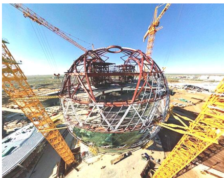
Рисунок 5 Процесс остекления фасада Сферы
