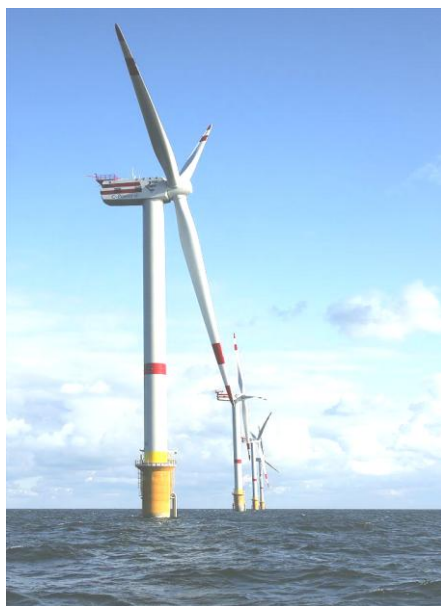
Рисунок 2 ВЭУ с горизонтальной осью вращения
